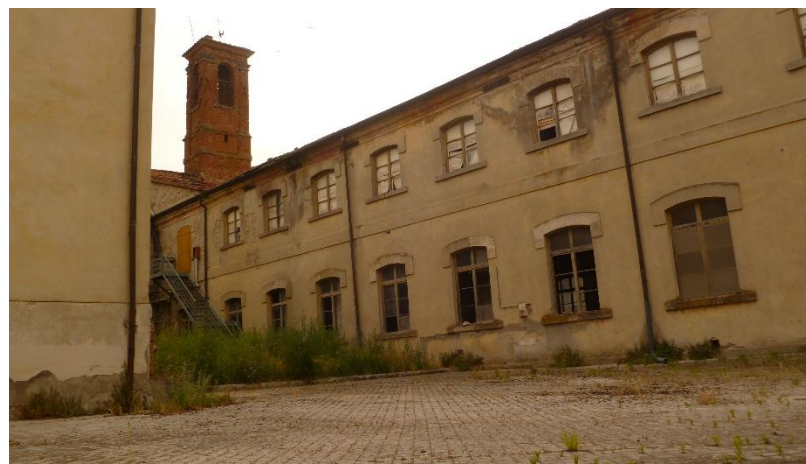
L'area dismessa dell'ex Manifattura Tabacchi a Sansepolcro
